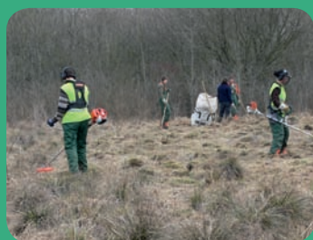
Chantier école de débroussaillage (BTS GPN, LEGTA Sées)
